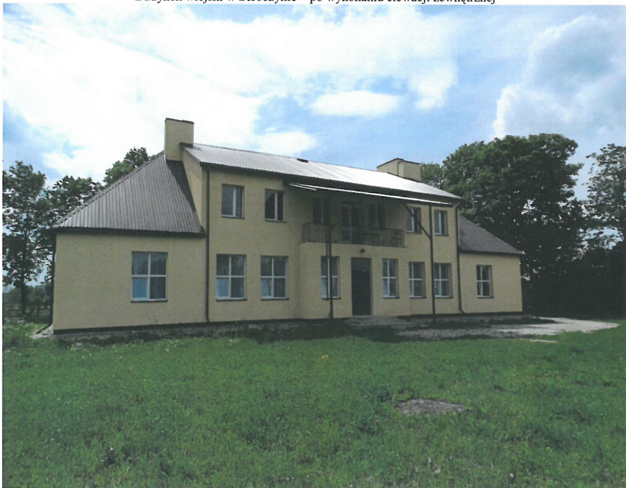
Budynek wiejski w Seroczynie – po wykonaniu elewacji zewnętrznej
