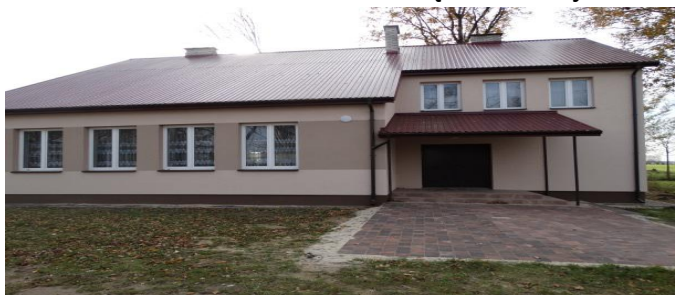
Utwardzenie placu i ułożenie chodnika przy świetlicy wiejskiej Wiśniewo
