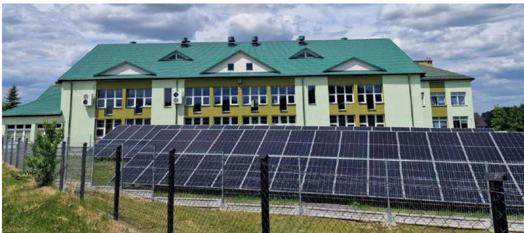
Zamontowane panele fotowoltaiczne przy budynku Szkoły Podstawowej w Czerwinie
