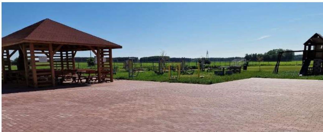
Wybudowany teren rekreacyjno–integracyjny w miejscowości Seroczyn
