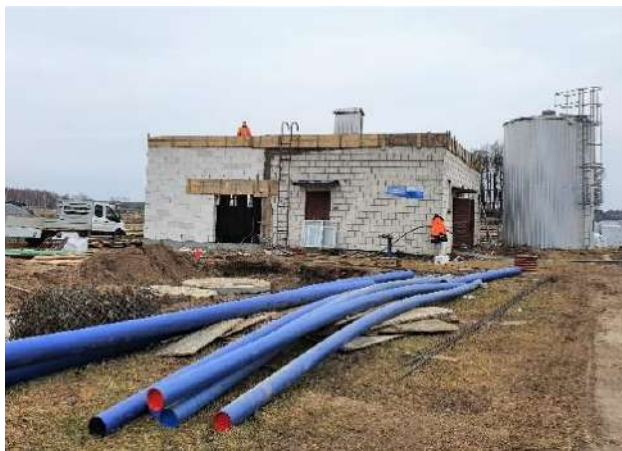
SUW Piski w trakcie Rozbudowy
