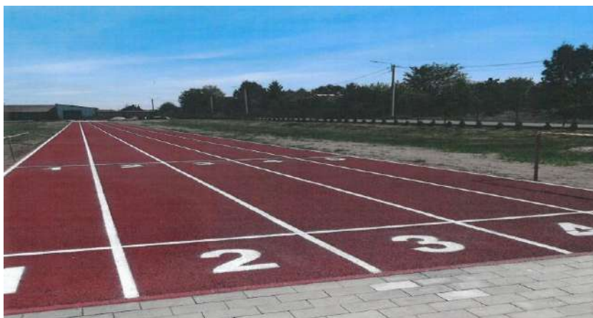
Zakończona budowa bieżni rekreacyjnej czterotorowej przy Szkole Podstawowej w Piskach
