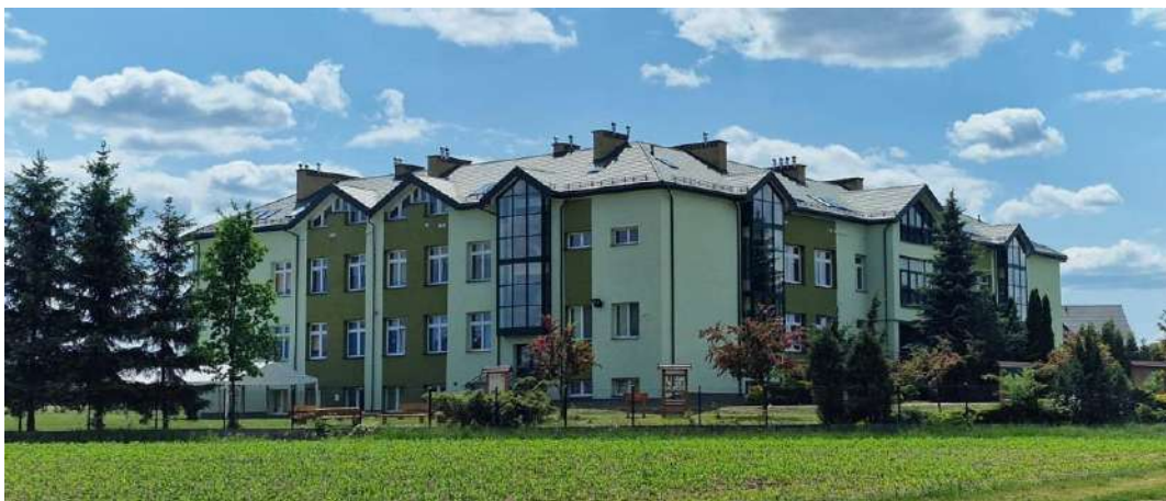
Budynek Szkoły Podstawowej w Czerwinie po wykonanej Termomodernizacji
