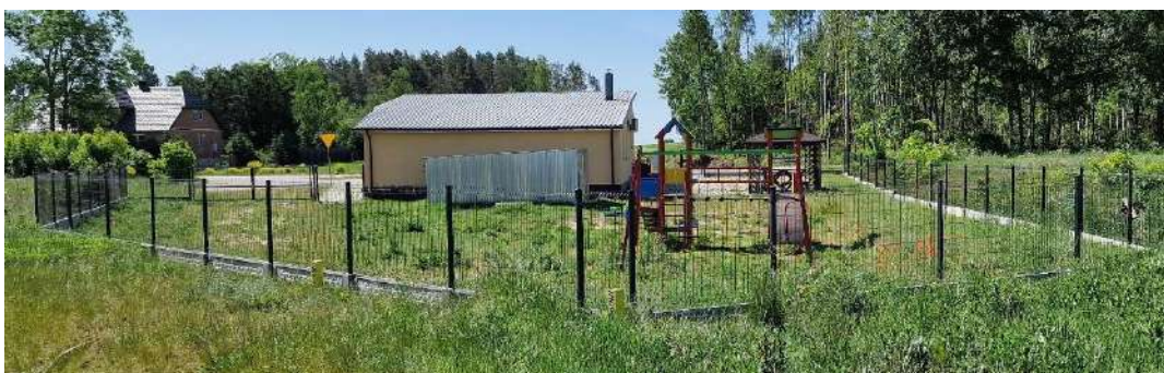
Wykonane ogrodzenie w miejscowości Gostery
