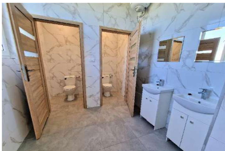
Zmodernizowane oraz wyremontowane pomieszczenia w budynku OSP Damiany
