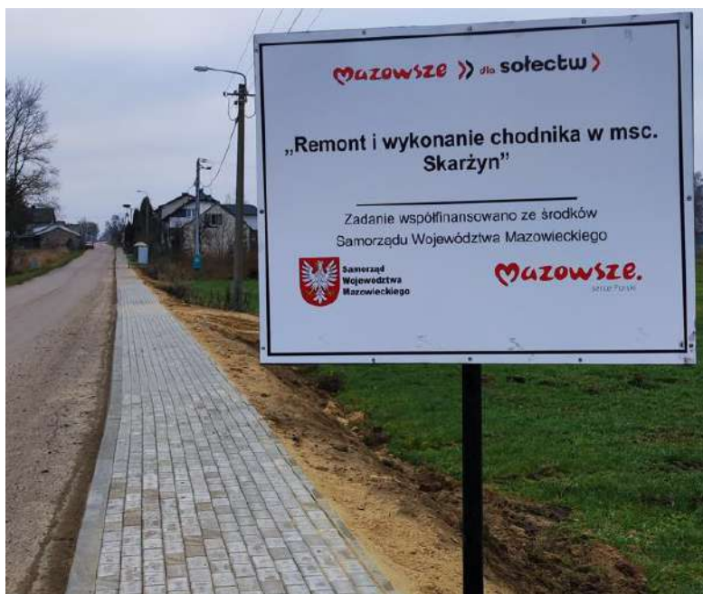
Wyremontowany i rozbudowany chodnik w miejscowości Skarżyn
