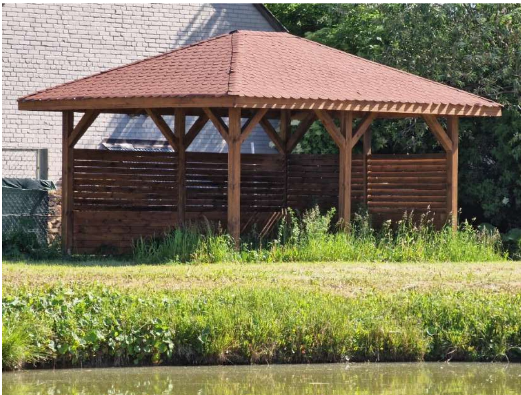
Wykonana Altanka w miejscowości Dobki Stare
