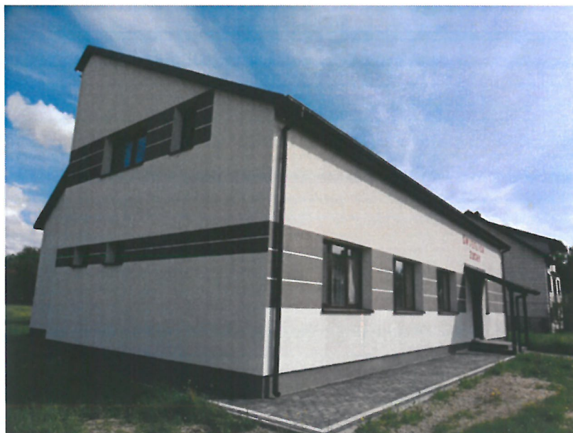
Remont świetlicy wiejskiej w msc. Żochy.
