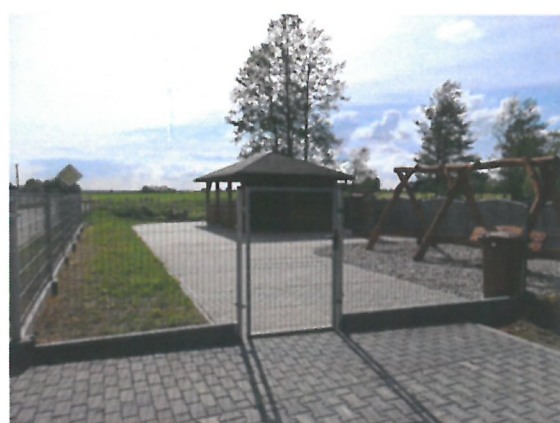
Zakup i ułożenie kostki brukowej na działce wiejskiej
