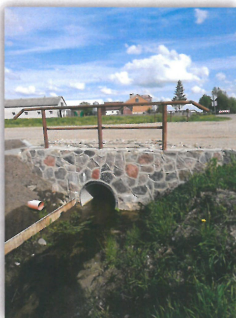
Remont mostku w Dobkach Starych.
