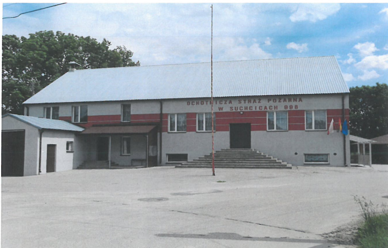
Budynek Ochotniczej Straży Pożarnej w Suchcicach po wykonaniu elewacji zewnętrznej
