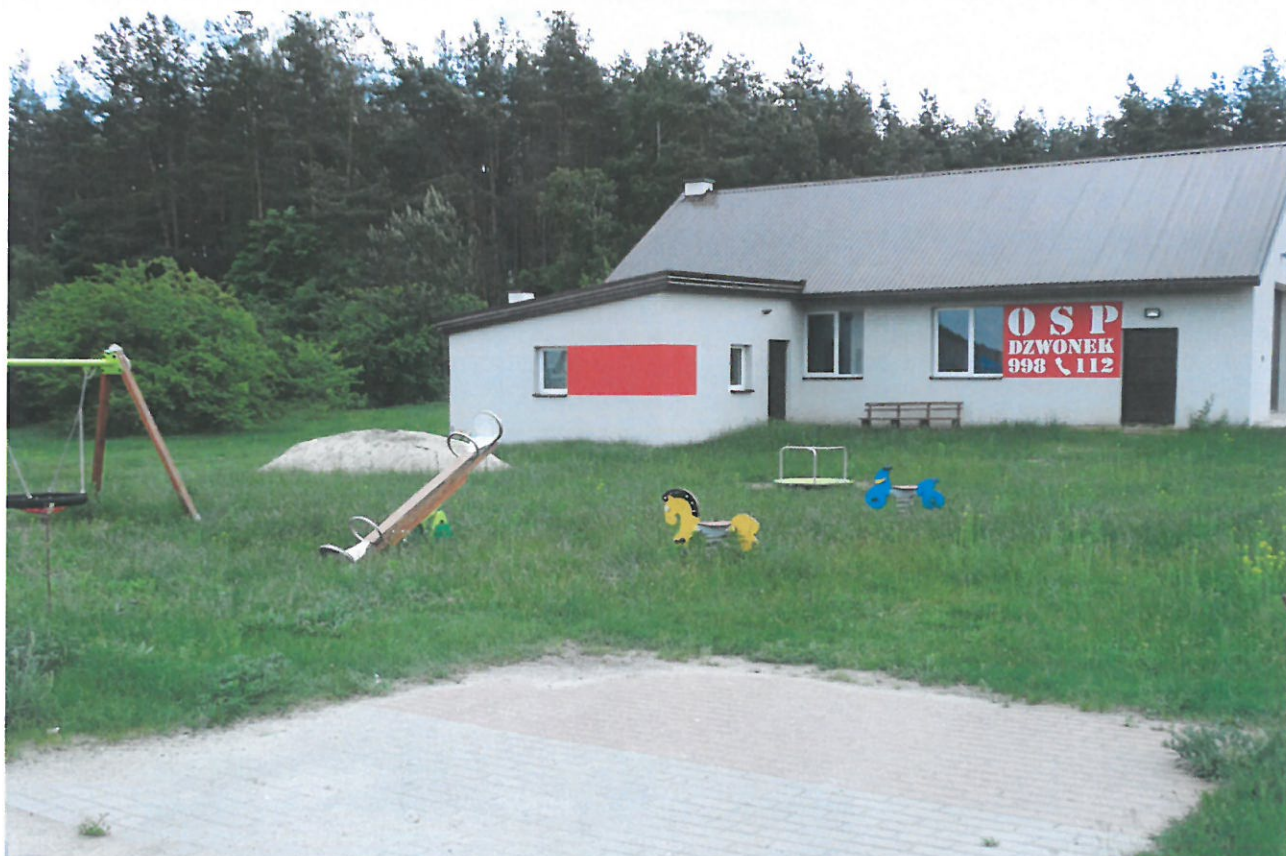
Budynek Ochotniczej Straży Pożarnej w Dzwonku, plac zabaw
